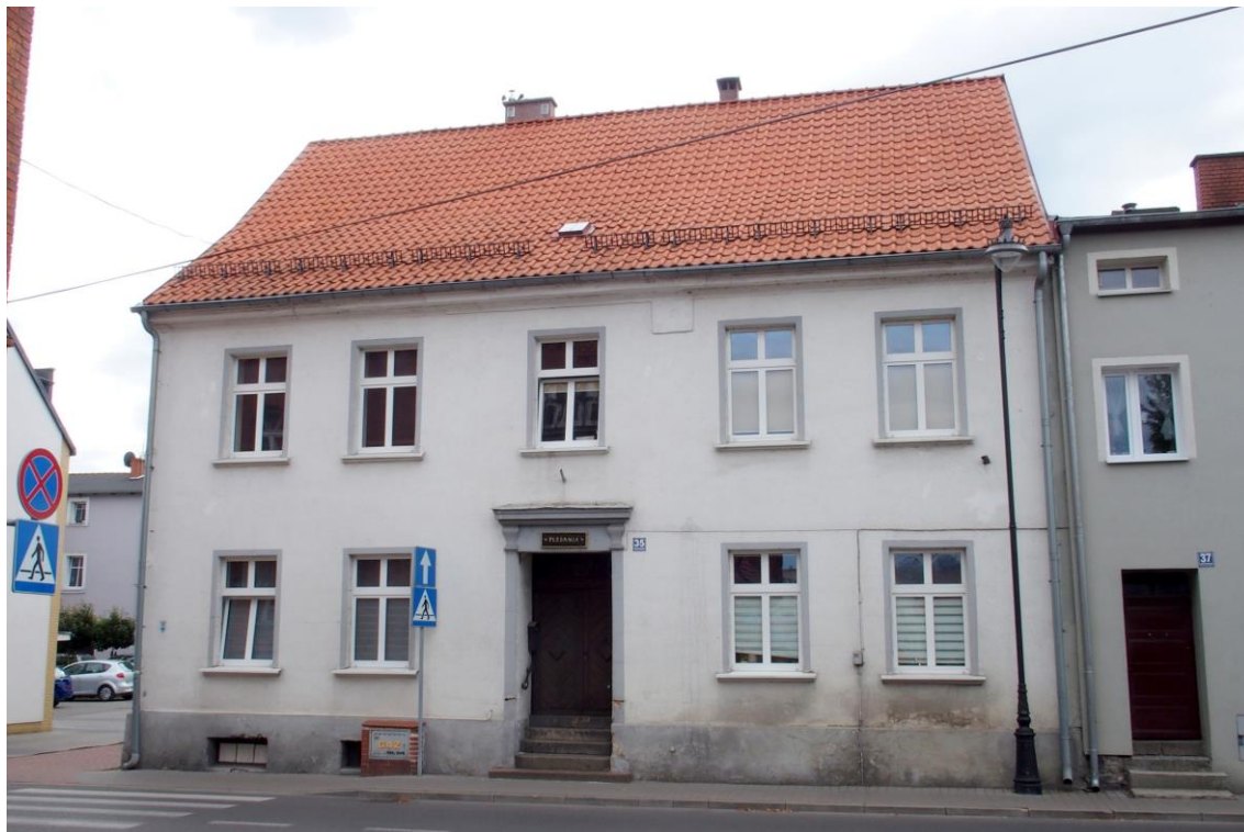
Widok budynku od wschodu
