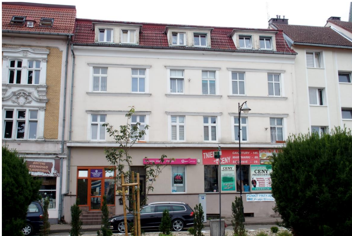
Widok budynku od wschodu
