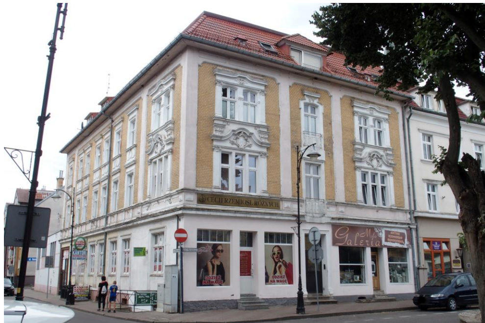
Widok budynku od południowego - wschodu
