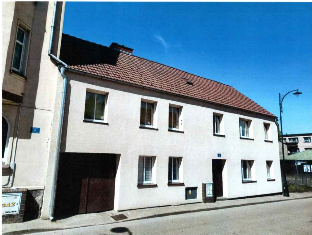
Widok budynku od wschodu
