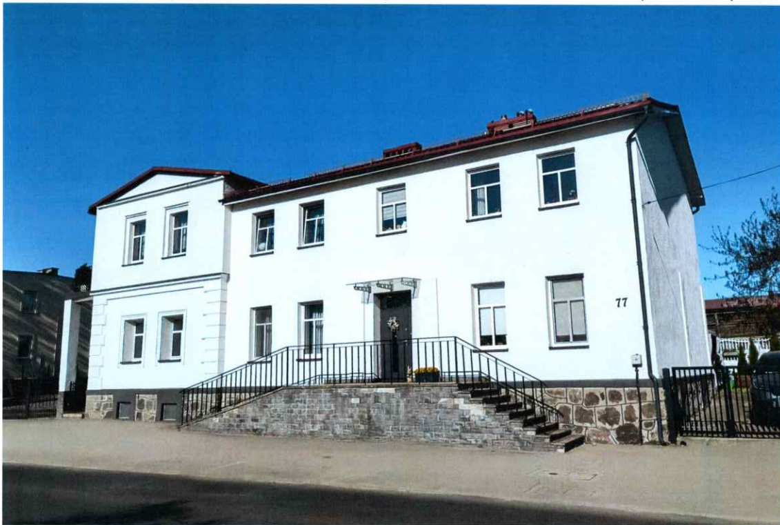
Widok budynku od południowego - zachodu
