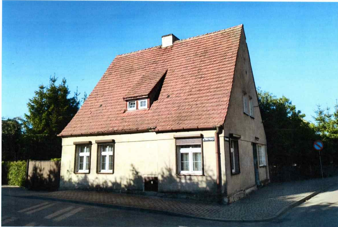
Widok budynku od południowego - zachodu
