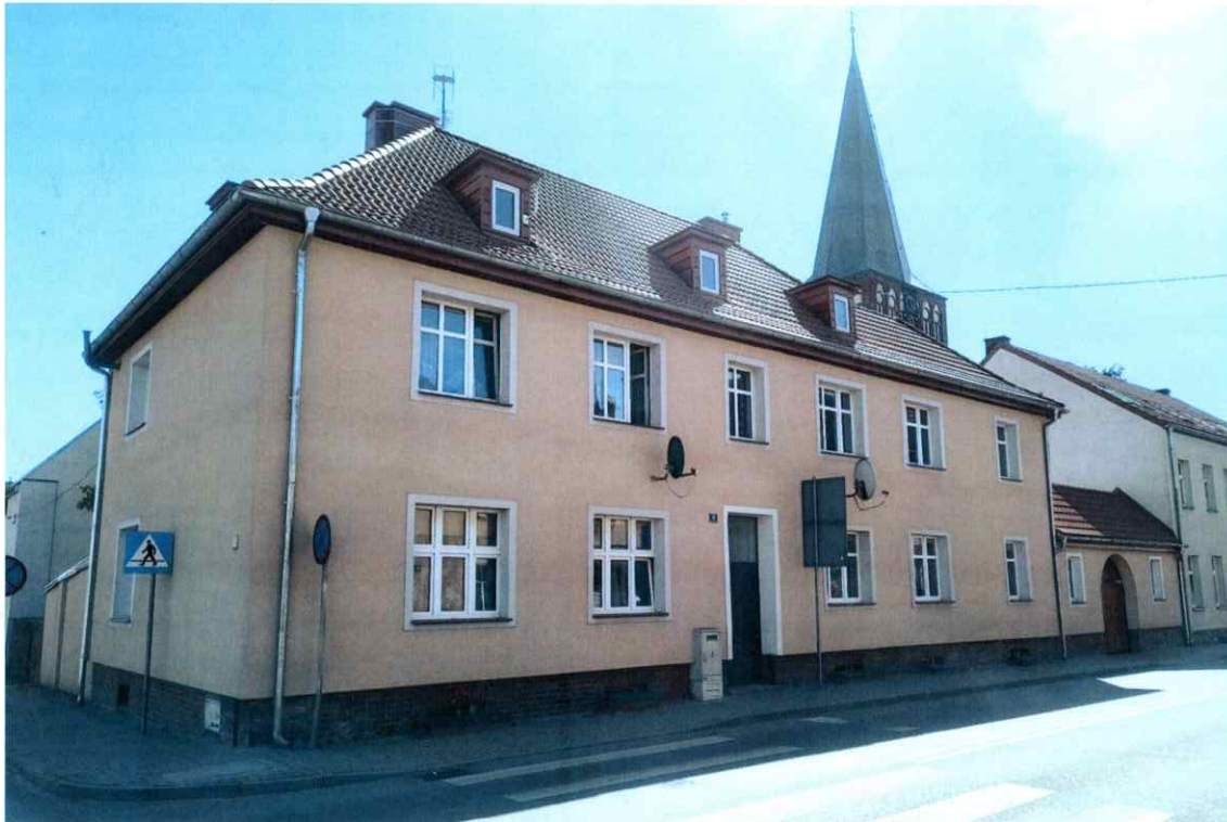
Widok budynku od północnego - zachodu
