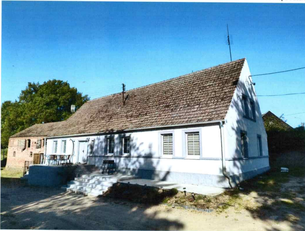
Widok budynku od północnego - wschodu
