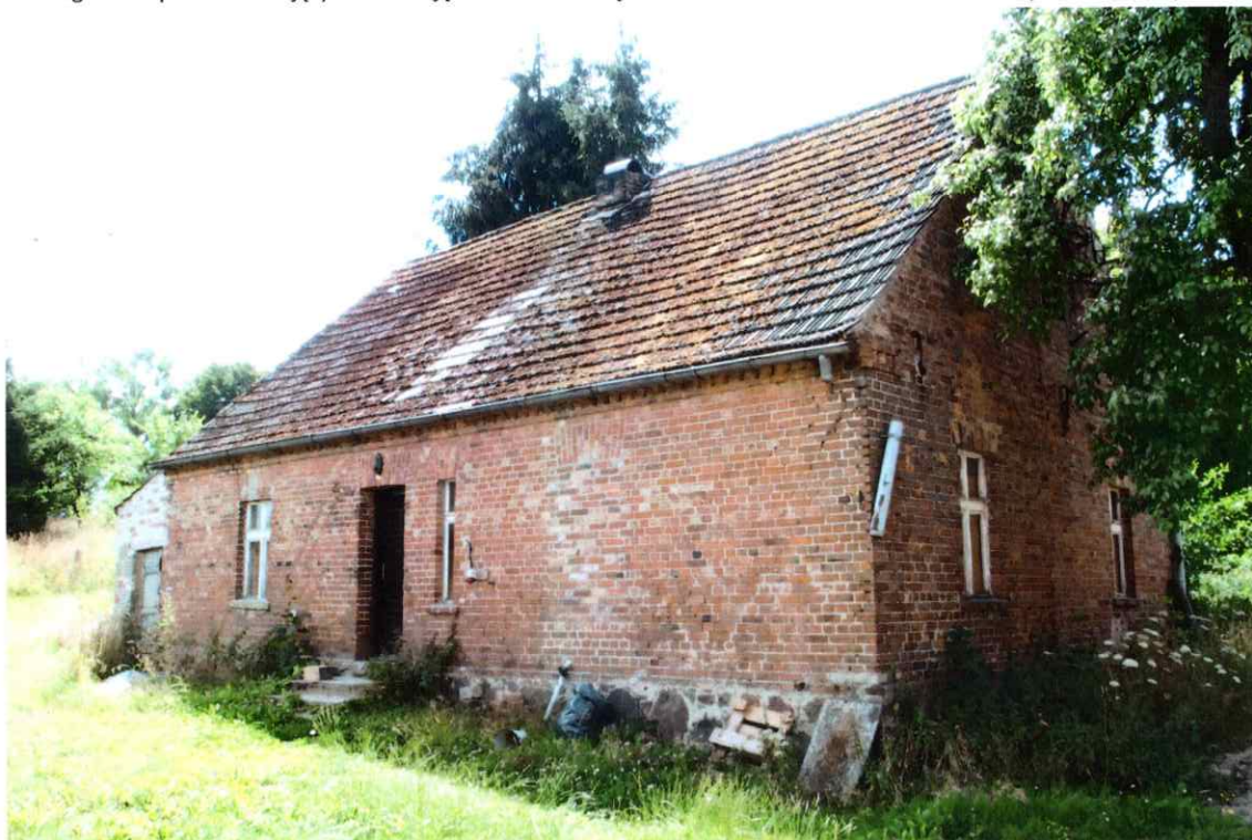
Widok budynku od południowego - wschodu
