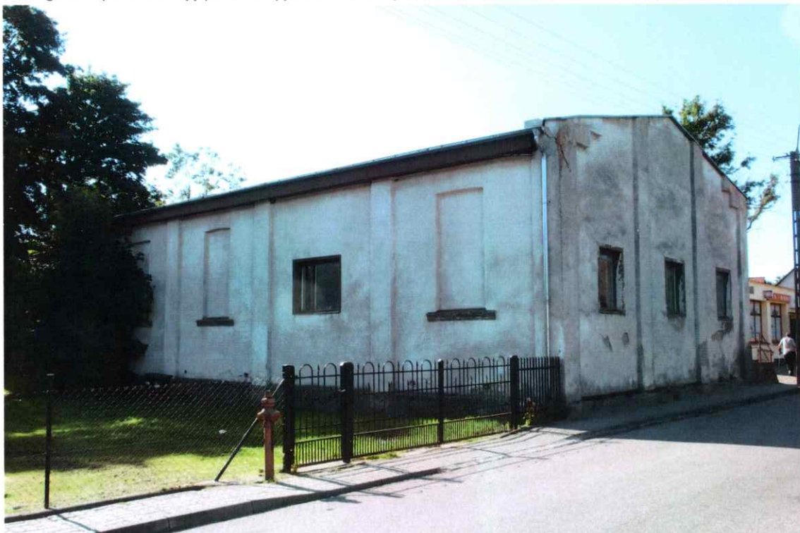
Widok budynku od północnego - zachodu
