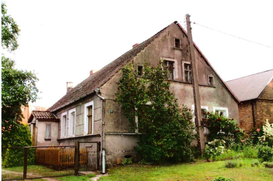
Widok budynku od północy
