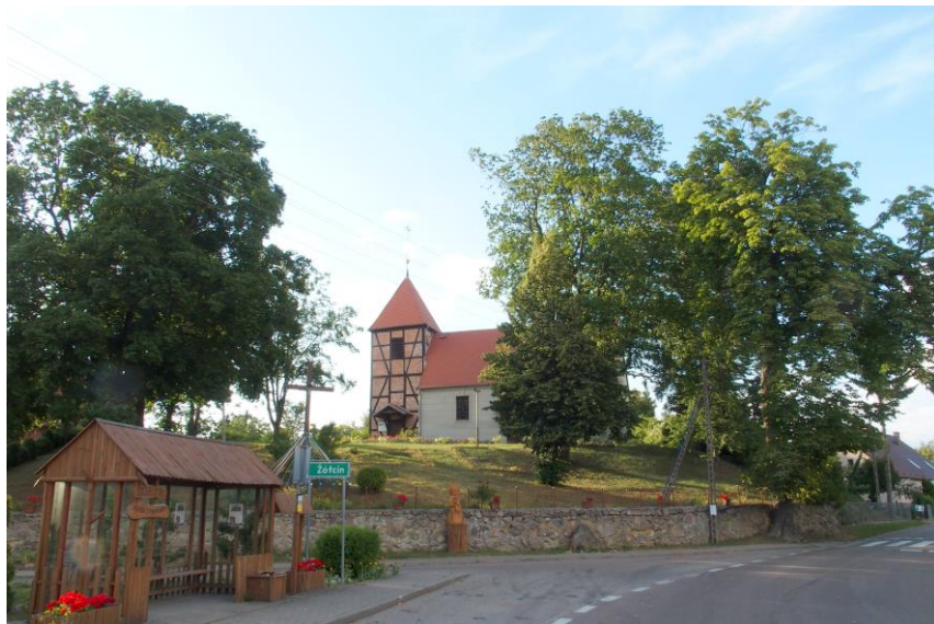
Widok od południowego - wschodu
