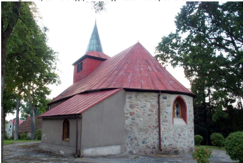
Widok od południowego - wschodu
