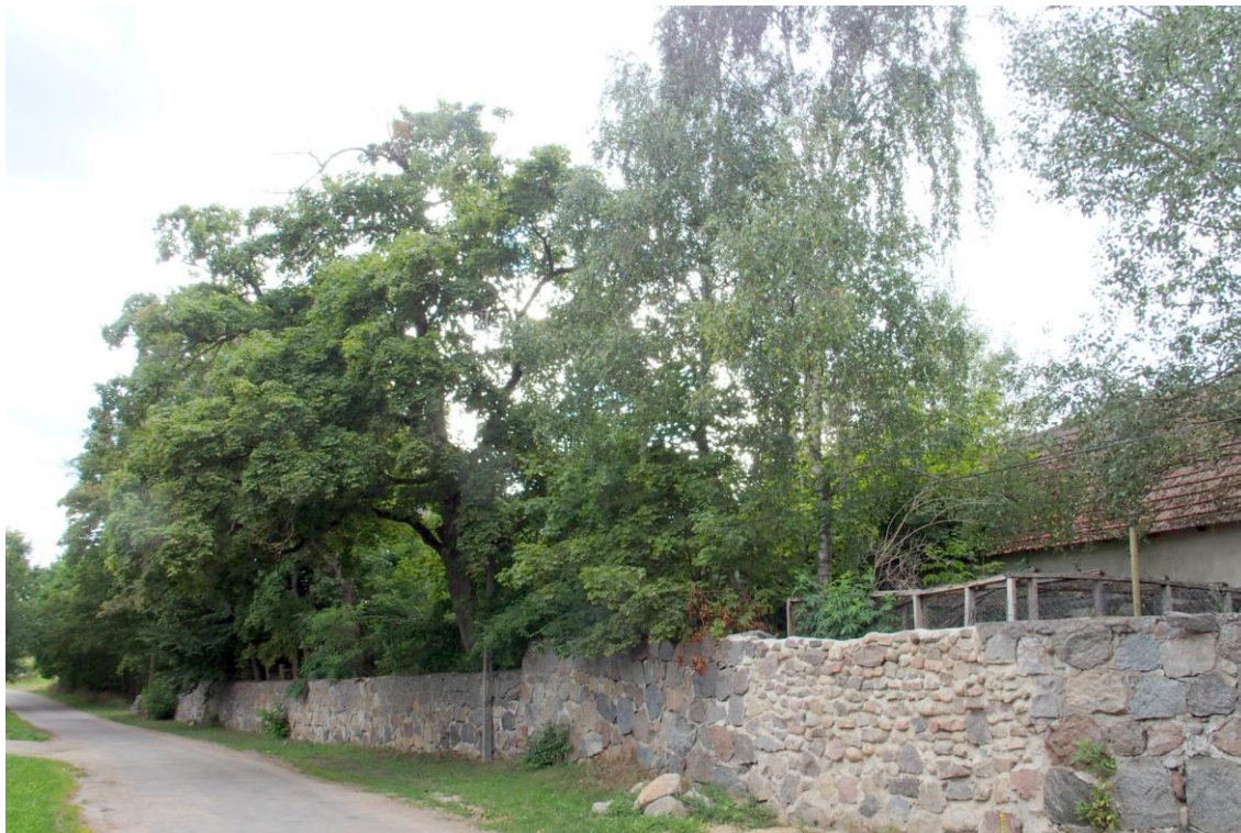
Widok od południowego - wschodu
