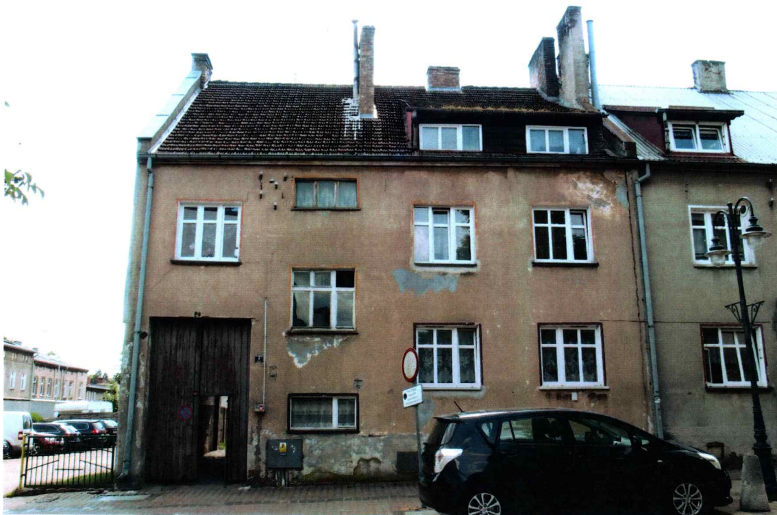
Widok budynku od północy
