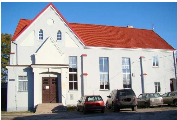
Zdjęcie archiwalne z 2010 r., źródło: karta gminnej ewidencji zabytków, autor: mgr Waldemar Witek „VERBUM” Szczecin, 11.2010 r.
