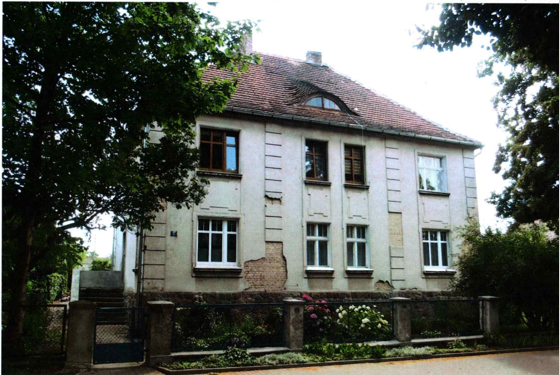
Widok budynku od północnego - zachodu
