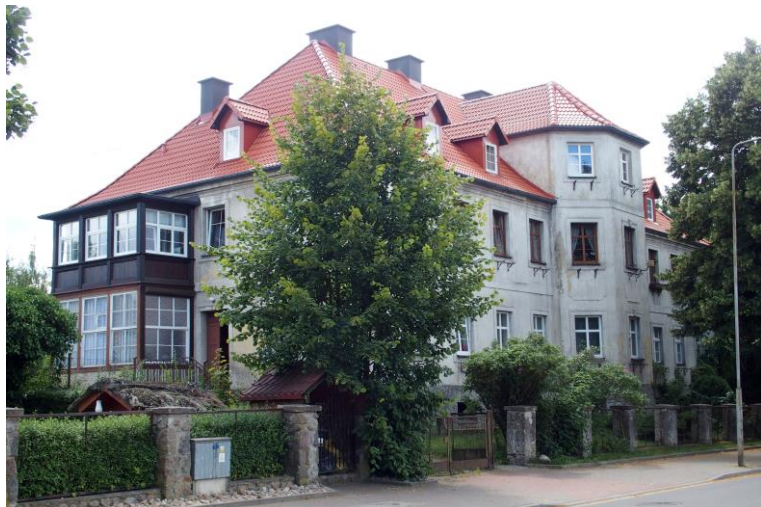
Widok budynku od północy
