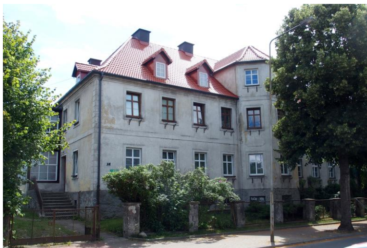
Widok budynku od północy
