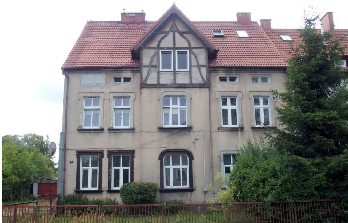
Widok budynku od wschodu
