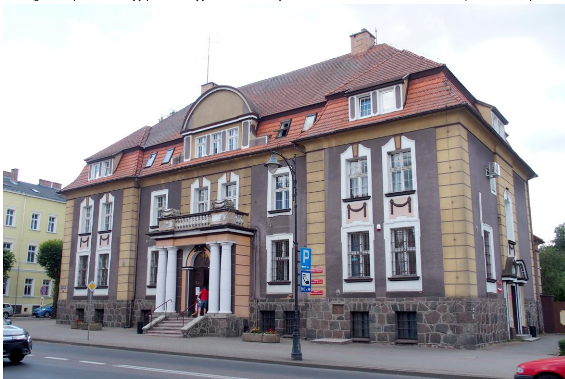
Widok budynku od północnego - wschodu
