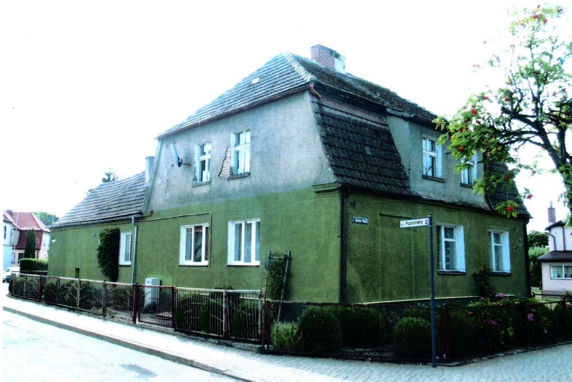
Widok budynku od wschodu
