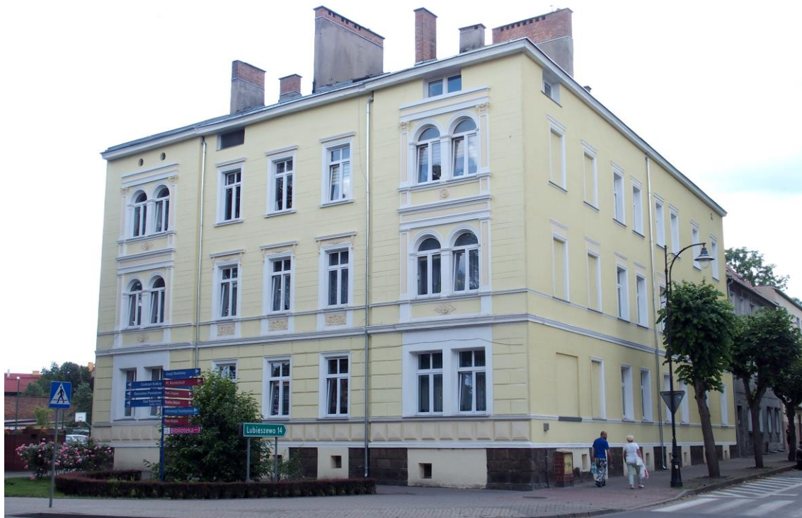
Widok budynku od północy
