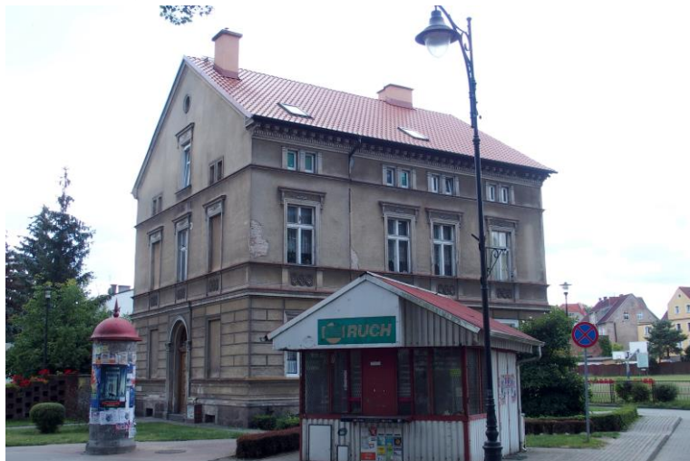
Widok budynku od północy
