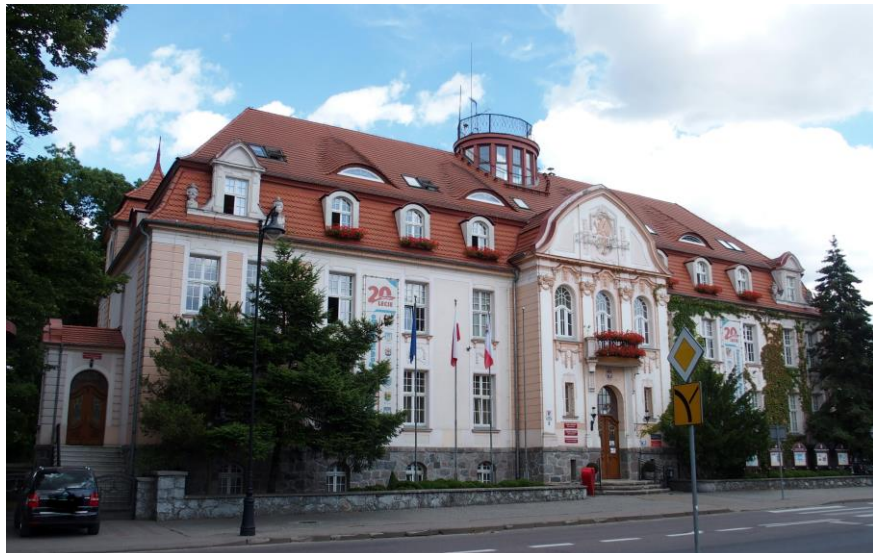
Widok budynku od południowego - zachodu
