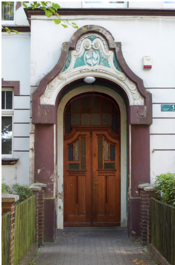
Widok detalu architektonicznego – portal
