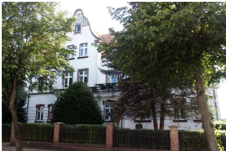
Widok budynku od północy
