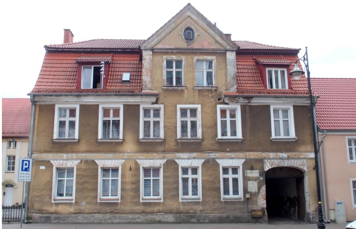
Widok budynku od północy
