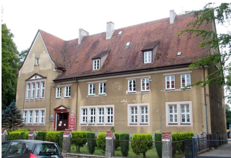
Widok budynku od północy
