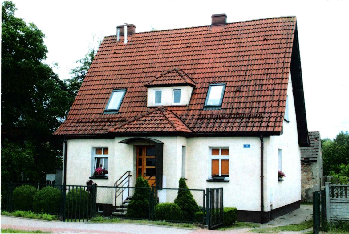
Widok budynku od północnego - zachodu
