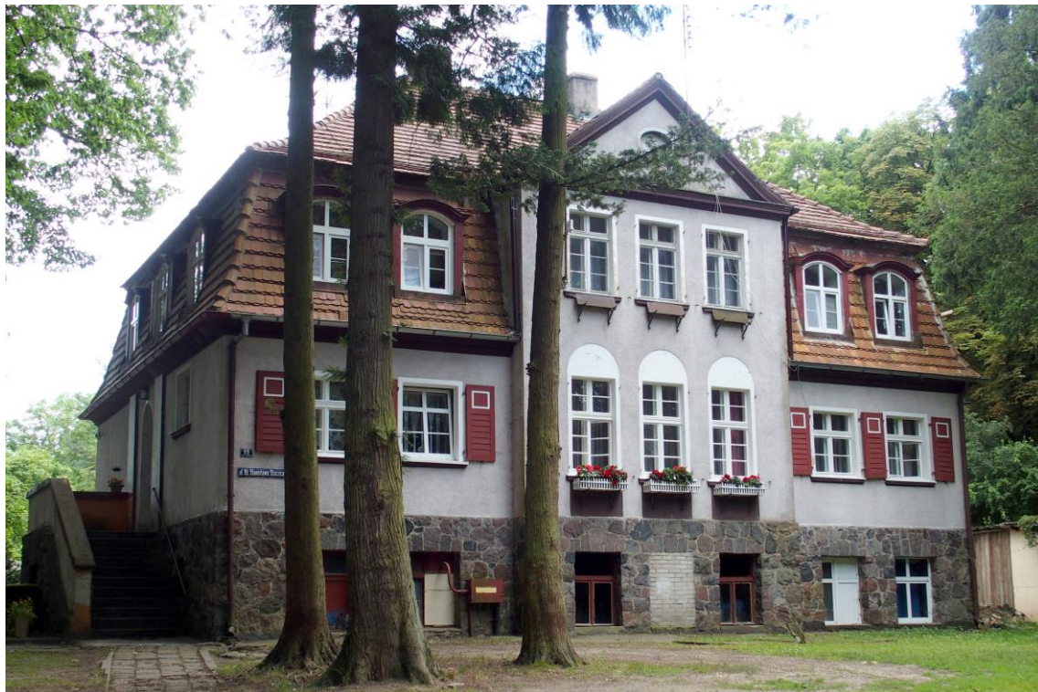
Widok budynku od północy
