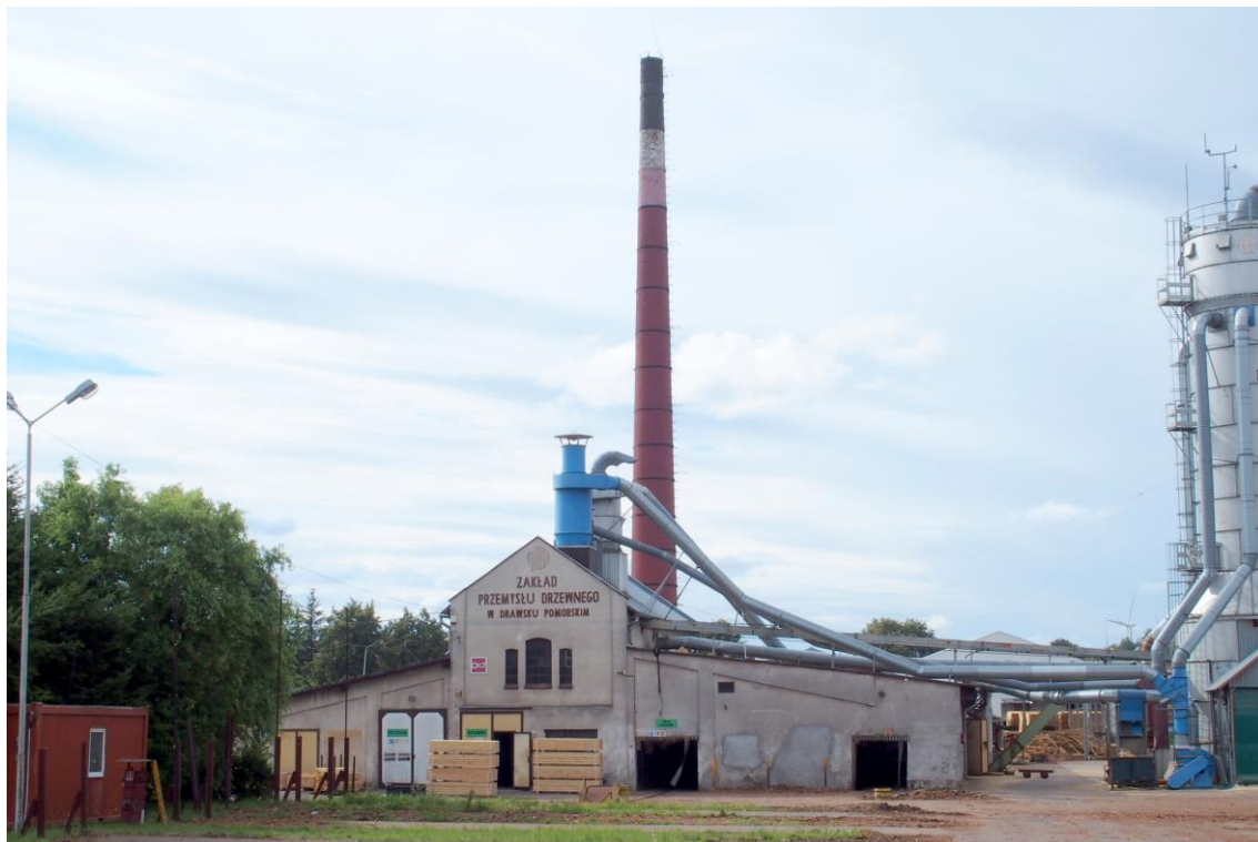
Widok budynku od południowego - wschodu
